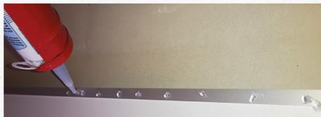
4. Stellen Sie nun die Platte auf und drücken Sie diese auf dem Alurahmen mäßig fest an die Wand, so dass sich das Silikon gut verteilen kann und eine gleichmäßige Klebewirkung erzielt. Bis zur vollständigen Aushärtung des Silikons, sollten Sie etwa 24h lang, schwere Gegenstände vor die Platte stellen und stützen um ein eventuelles umkippen zu vermeiden.
